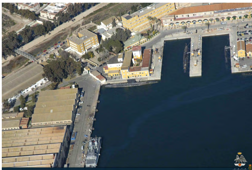
Figura 9 SEGUNDA FASE DE LA REMODELACIÓN Y DESTRUCCIÓN DE LOS DIQUES DE FERINGÁN PARA LA CREACIÓN DE LA BASE DE SUBMARINOS DE CARTAGENA
