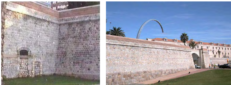
Figura 17 ESTADO ACTUAL DE LA MURALLA DE CARLOS III DESPUÉS DE LA RESTAURACIÓN
