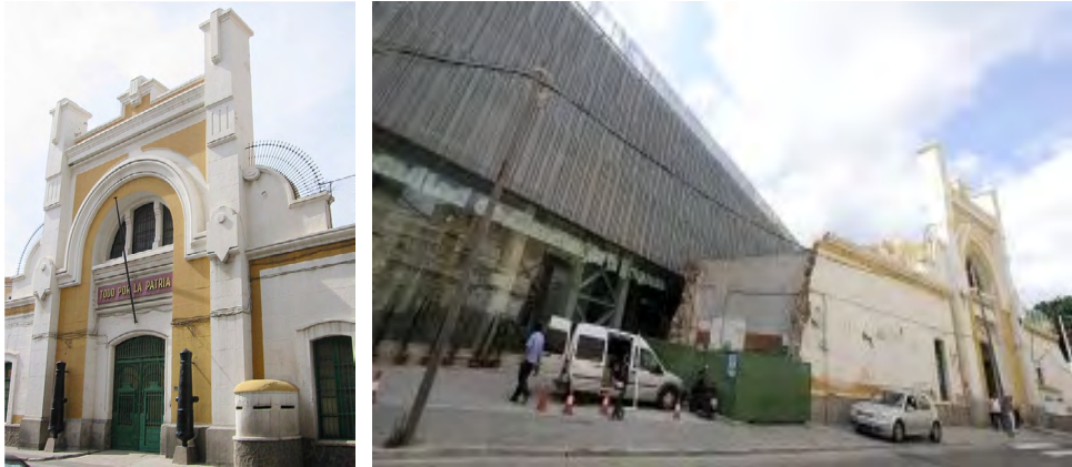
Figura 18 PORTADA DEL ANTIGUO CUARTEL DE INSTRUCCIÓN DE MARINERÍA Y SU ESTADO POCO ANTES DE DECIDIRSE SU CONSERVACIÓN
