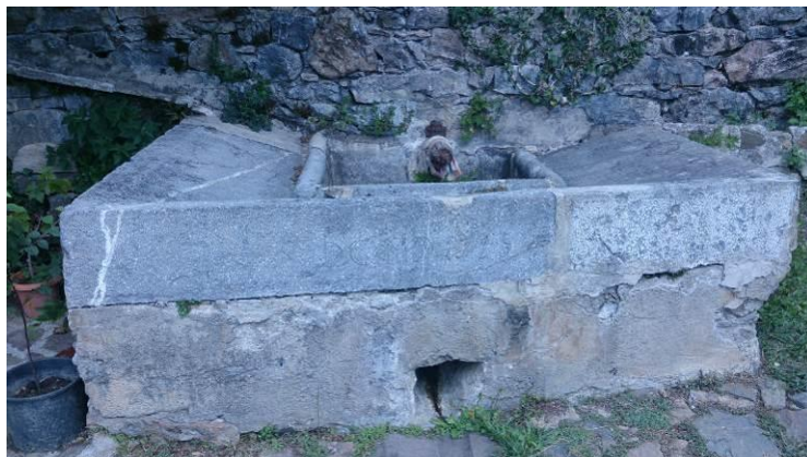
Cantabria. Enterrías. Casa de las Doñas. Detalle del lavadero. Foto: Soledad Pérez Mateo
