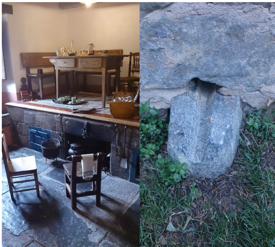
Cantabria. Enterrías. Casa de las Doñas. Cocina y su conducto de evacuación al exterior. Foto: Soledad Pérez Mateo
