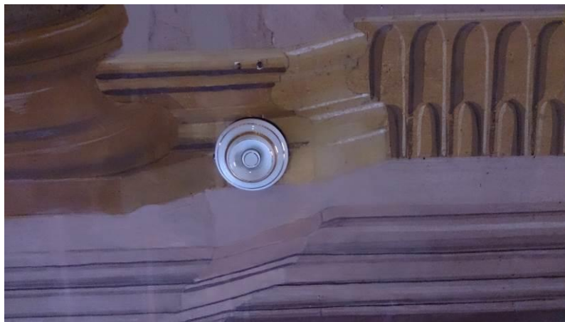
Murcia. Lorca. Palacio Guevara. Salón Amarillo. Detalle de uno de los interruptores originales. Foto: Soledad Pérez Mateo
