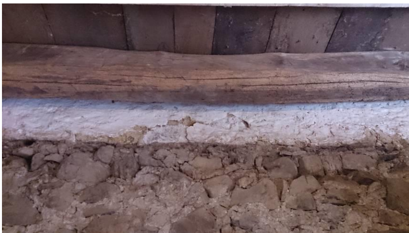
Cantabria. Enterrías. Casa de las Doñas. Detalle del techo desde el sótano, en el que se aprecian los diferentes niveles de construcción de la casa. Foto: Soledad Pérez Mateo
