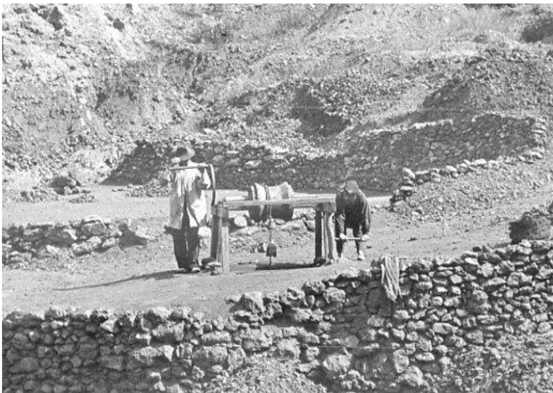
5. Sistema de elevación por torno manual utilizado en un pozo minero. Era movido por tracción humana y sólo podía utilizarse en pozos poco profundos. Su uso (aunque muy reducido) llegó a coexistir con el malacate y la máquina de vapor. Año 1895. Fotografía de autor desconocido.
