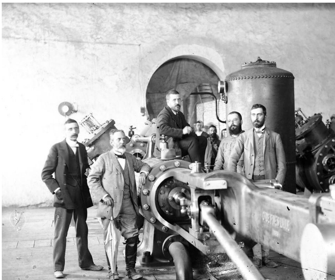
15. Técnicos de la Compañía de Águilas junto a una máquina de vapor para el pozo de extracción de la mina. En sus semblantes se adivina el dominio sobre la naturaleza, a la que han sometido con sus artefactos mecánicos movidos por la combustión del carbón y el impulso del vapor. Fotografía Gillman. Hacia 1880.
