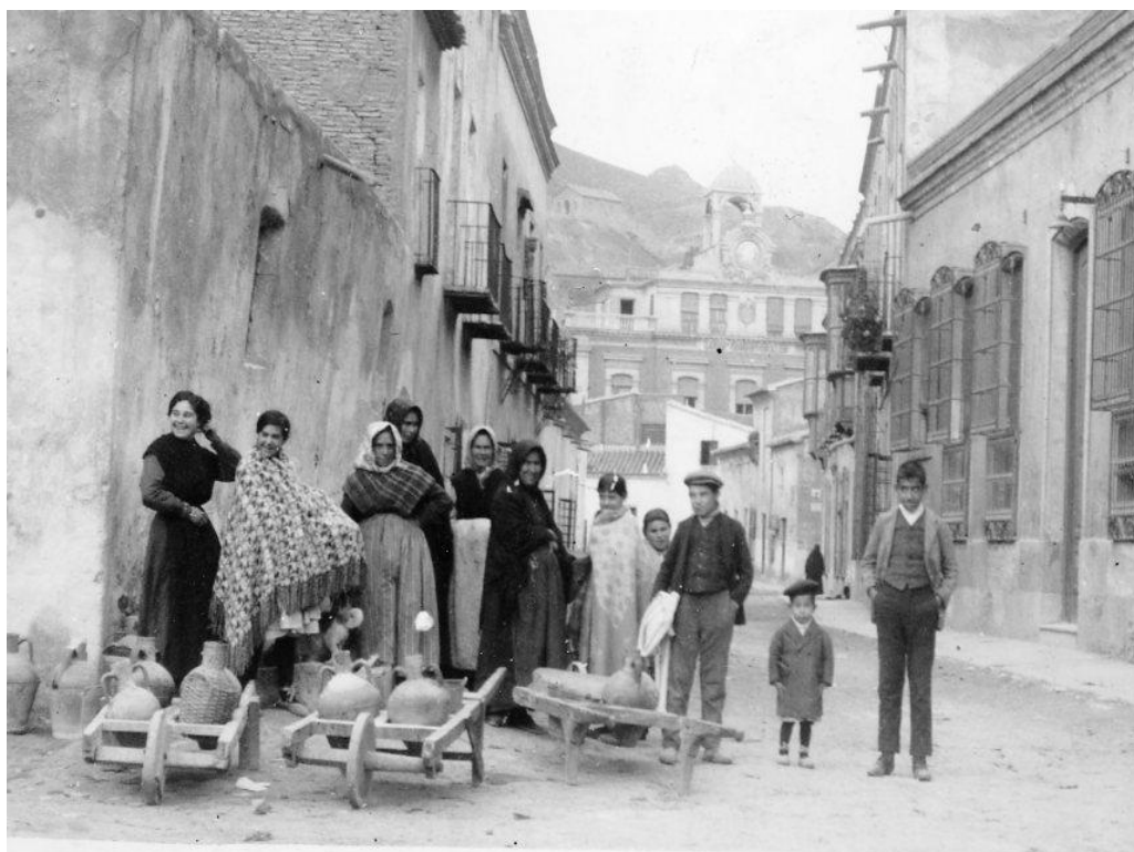
11. Mujeres llenando sus cántaros en la fuente pública de Barrionuevo, inaugurada en 1868. Las colas para surtirse de agua potable llegaron a ser habituales de noche y de día en Mazarrón, siendo lugares donde se establecían relaciones sociales entre la población autóctona y los grandes flujos migratorios. Fotografía La Industrial Valenciana. Años 1910-12.
