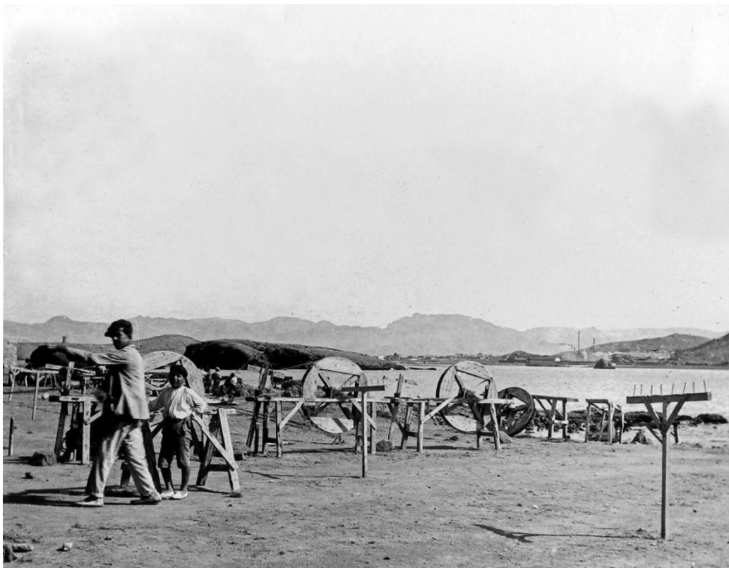
7. Fábrica de esparto en las playas del Puerto. Observamos a los trabajadores en la orilla del mar procediendo a la preparación del esparto después de haber sido «cocido». Así se conseguía favorecer el tratamiento posterior con mazos para el hilado. Año 1915. Fotografía de autor desconocido.
