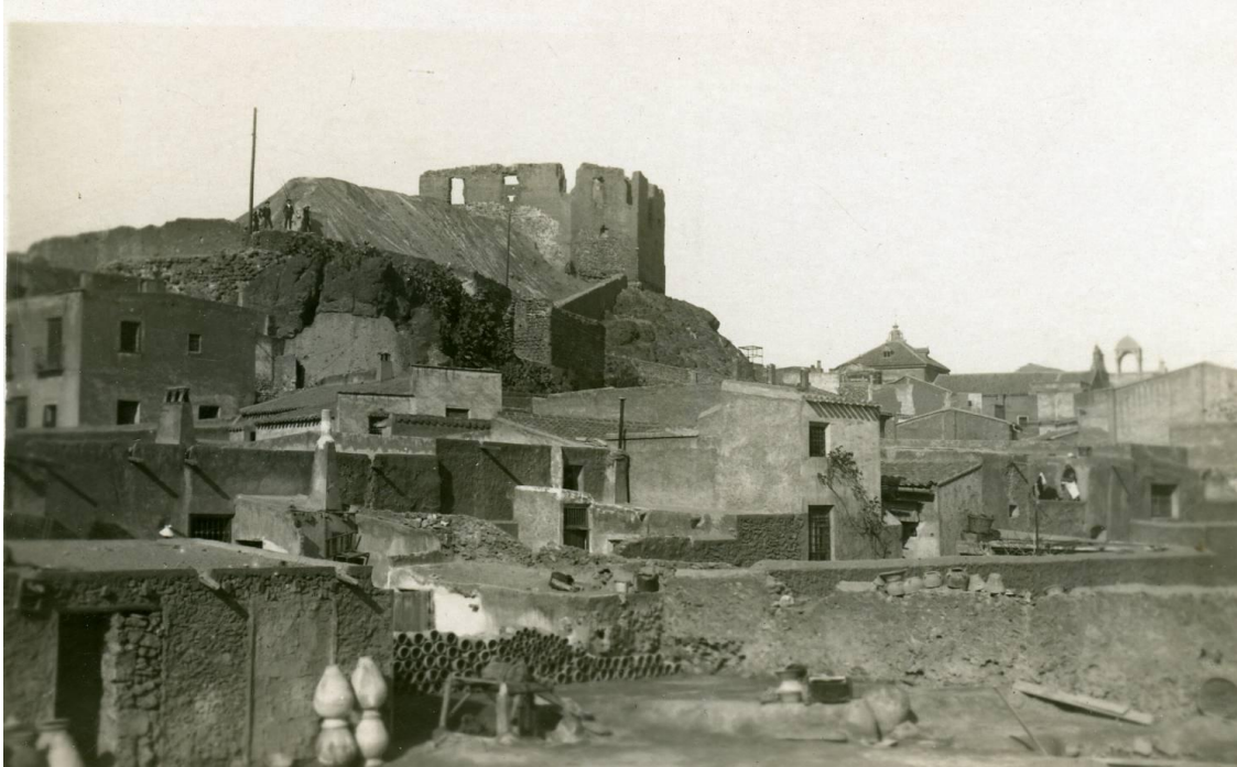
29. El castillo de Los Vélez sobre un promontorio en el centro de la población, muy deteriorado y casi enterrado por terreras provenientes de la perforación de un pozo en su interior y de restos del lavadero de mineral que fue instalado dentro del mismo recinto. Fotografía de la Industrial Fotográfica Valencia. Año 1910.
