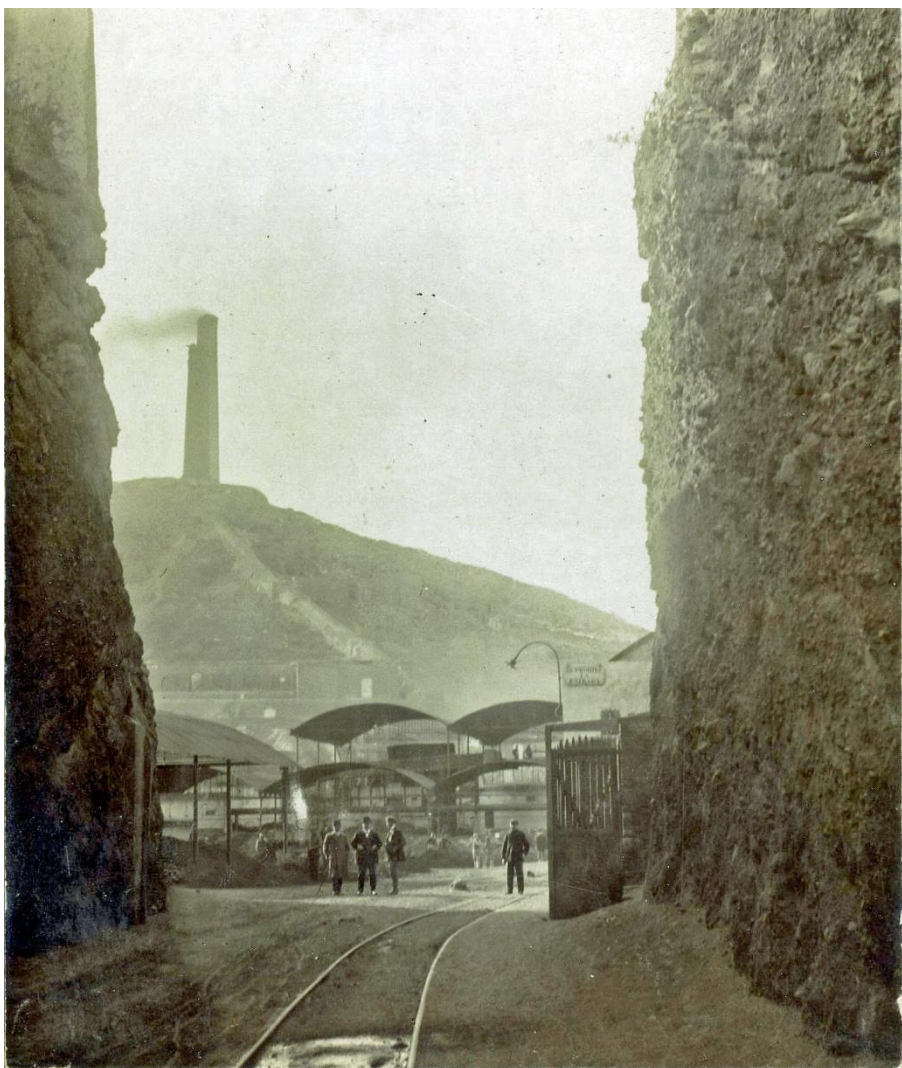
23. Fundición de plomo Santa Elisa en el Puerto de Mazarrón. Entrada principal con acceso de vía férrea para transporte del mineral. La factoría, conocida como «La Metalúrgica», estaba considerada como una de las fundiciones más modernas de España, modelo de productividad y alta tecnología. Fotografía Hans Nonnast. Año 1905.
