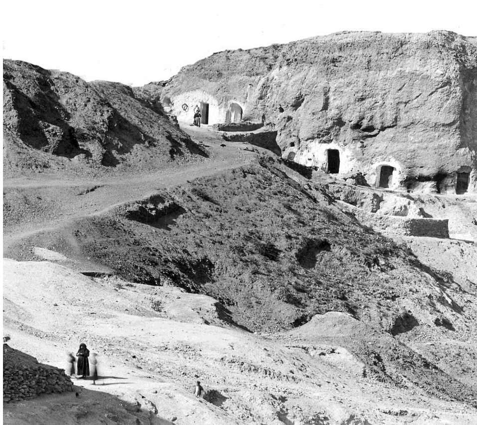
19. Casas-cueva en las inmediaciones del «Charco de La Aguja» de Mazarrón. Muy cerca de las explotaciones mineras se avecindaron un gran número de familias provenientes de la provincia de Almería, donde, por otra parte, abundaban este tipo de construcciones. Hacia 1910. Fotografía de autor desconocido.
