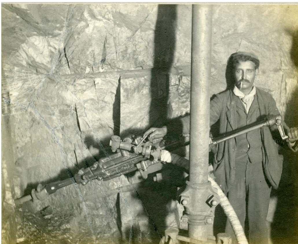
20. Perforadora horizontal de aire comprimido instalada en la mina Santa Ana de Mazarrón a finales de siglo XIX. Esta herramienta supuso un gran adelanto, pues podía ser utilizada para la perforación de barrenos y avanzar mucho más rápido en la explotación de filones. Fotografía archivo Compañía de Águilas.
