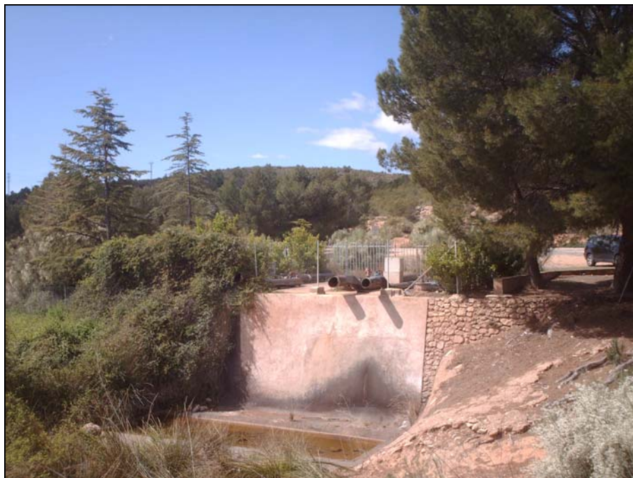
Fotografía 8. Localización de batería de bombeo de ensayo de larga duración.
