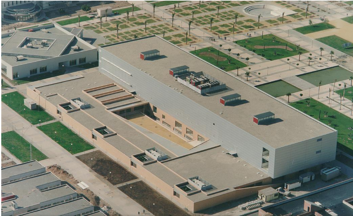
Fig. 33. Vista área desde el sureste 147 .
