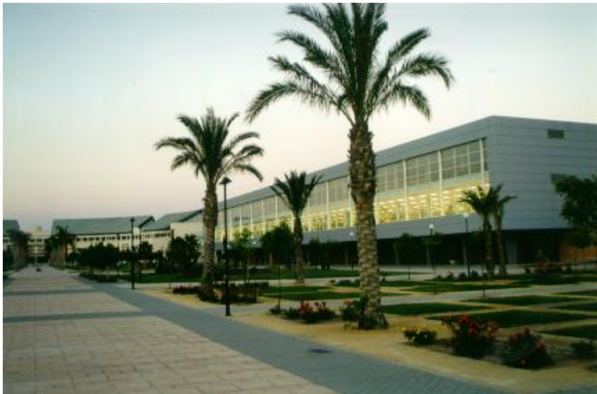
Fig. 31. Vista de la biblioteca desde el noroeste.
