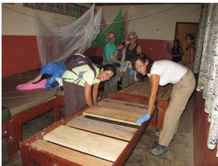
Figura 31. Adecuación de las diferentes estancias. En concreto, se aprecia en la imagen una dedicada a la Reanimación.
