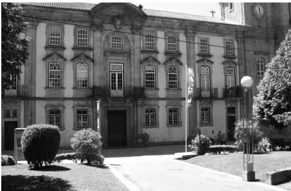
Ilustração 1 - Edifício dos Congregados
