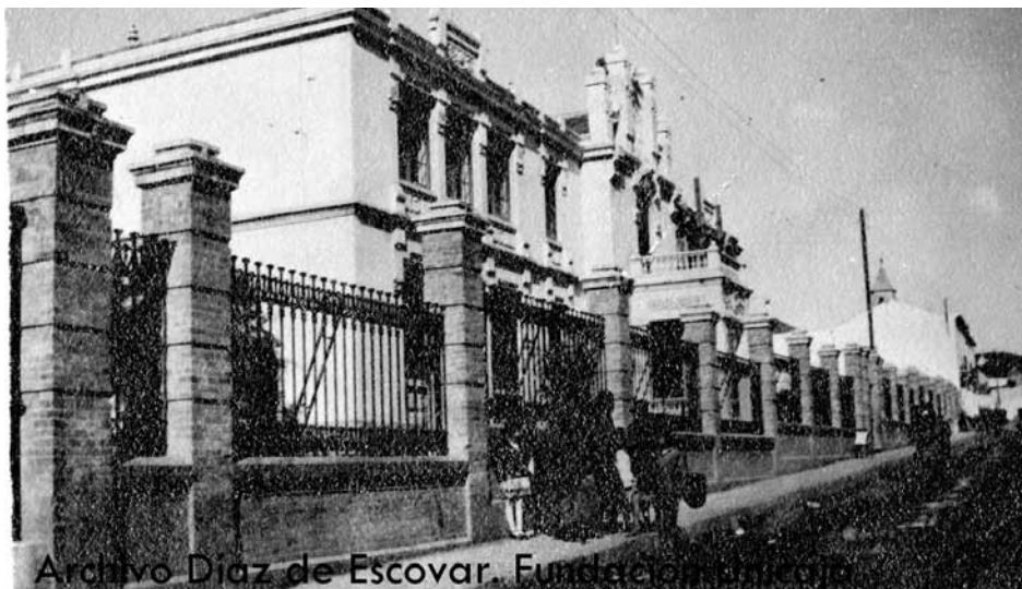
Fuente: Fachada del grupo escolar Bergamín (1921?). Archivo Díaz Escovar, nº 2017.
