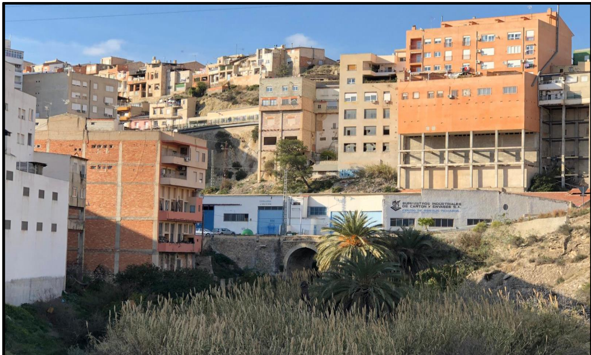
Foto 16: Casco urbano de Abarán. Foto propia
