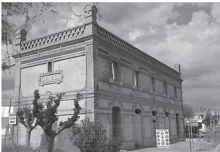
FOTO 3: ANTIGUA ESTACIÓN DE CARAVACA:
