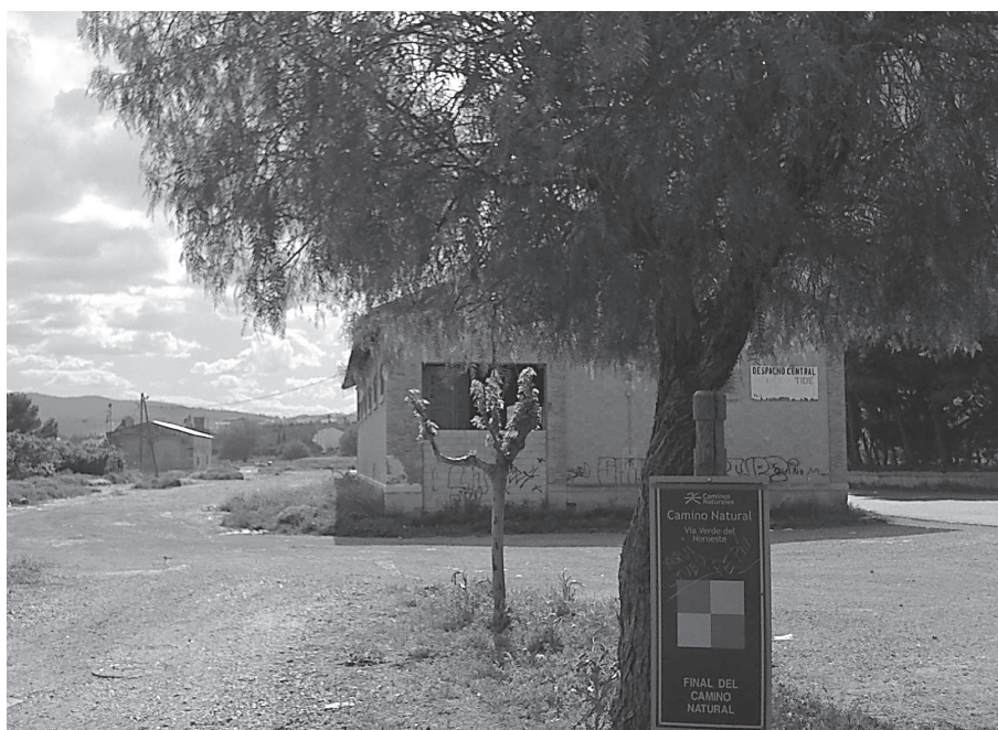
FOTO 4: ESTACIÓN DE CARAVACA: FINAL DEL CAMINO NATURAL DE LA VÍA VERDE DEL NOROESTE.
