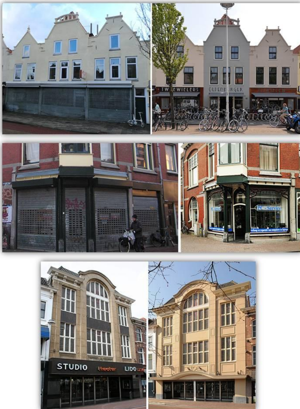
Ilustración 3.9: Programa de tratamiento de fachadas – Varias intervenciones realizadas, Leiden (Países Bajos)
