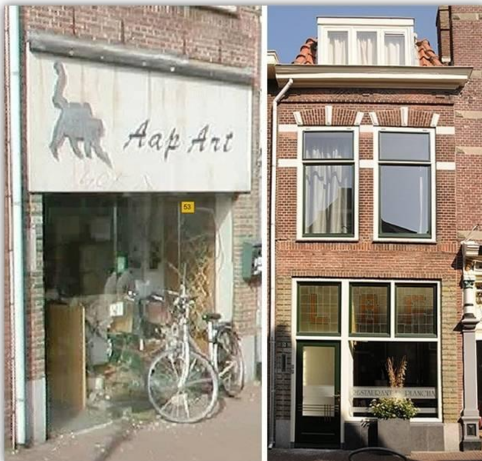
Ilustración 3.11: Programa de tratamiento de fachadas – Varias intervenciones realizadas, Leiden (Países Bajos)
