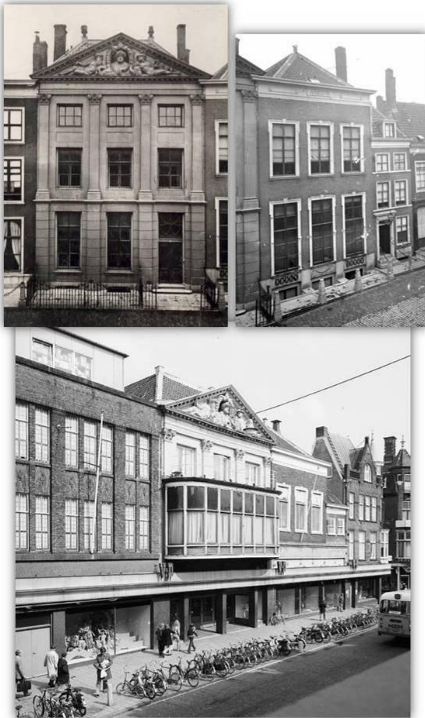
Ilustración 3.7: Programa de tratamiento de fachadas – Intervención en Breestraat 84-86: imágenes históricas, Leiden (Países Bajos)
