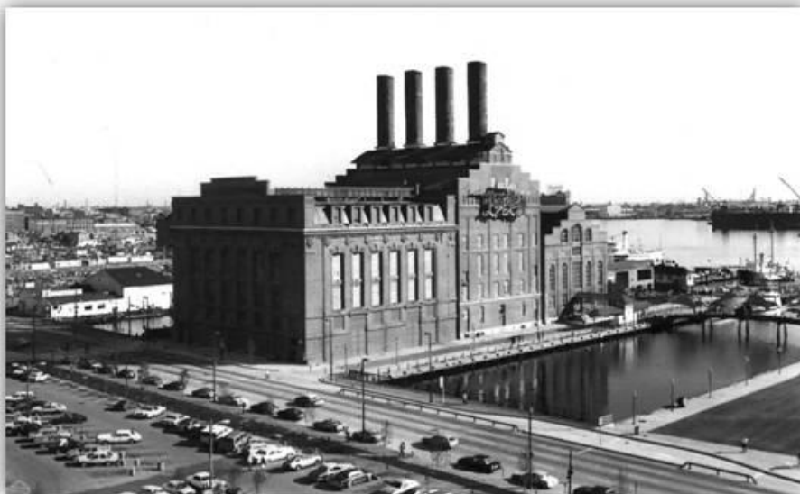
Ilustración 3.25: Central eléctrica de la calle Pratt. Inner Harbor, Baltimore (Estados Unidos)
