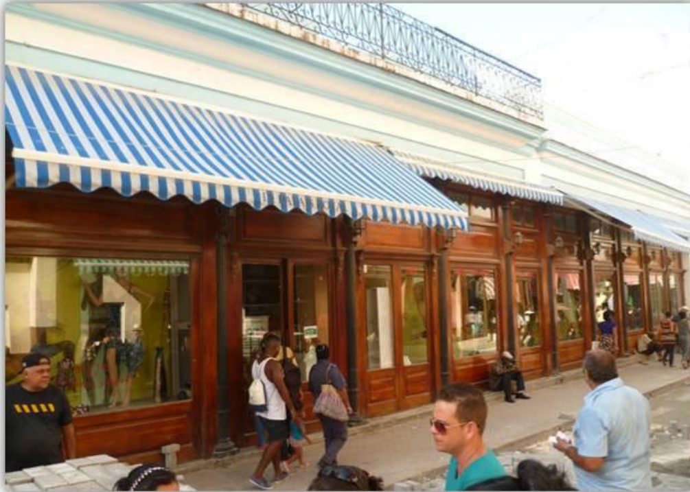
Ilustración 3.24: Recuperación de fachadas comerciales históricas, La Habana (Cuba)
