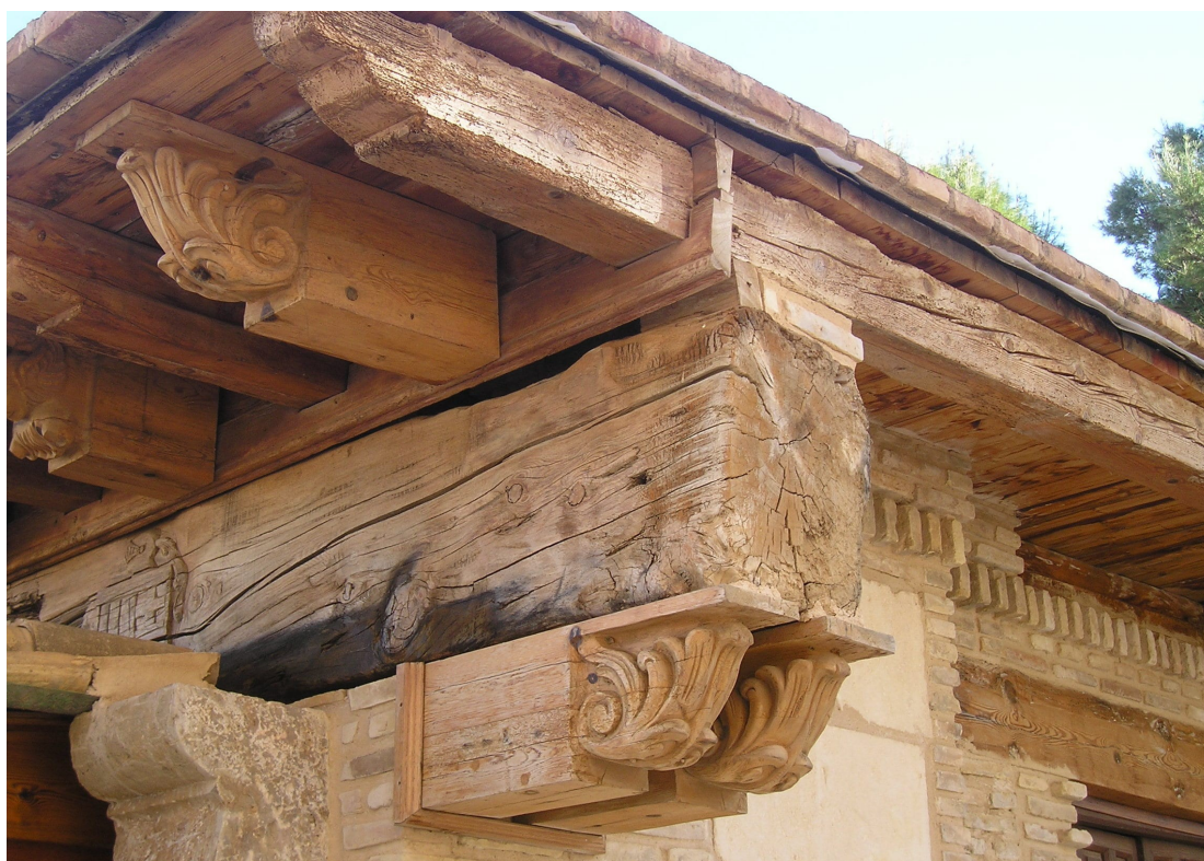
Imagen 25 y 26: Castillo de Ros de Olano en Balsicas (Murcia). Abajo detalle de las vigas de madera de Segura de la Sierra procedentes de uno de los diques secos del arsenal de Cartagena
