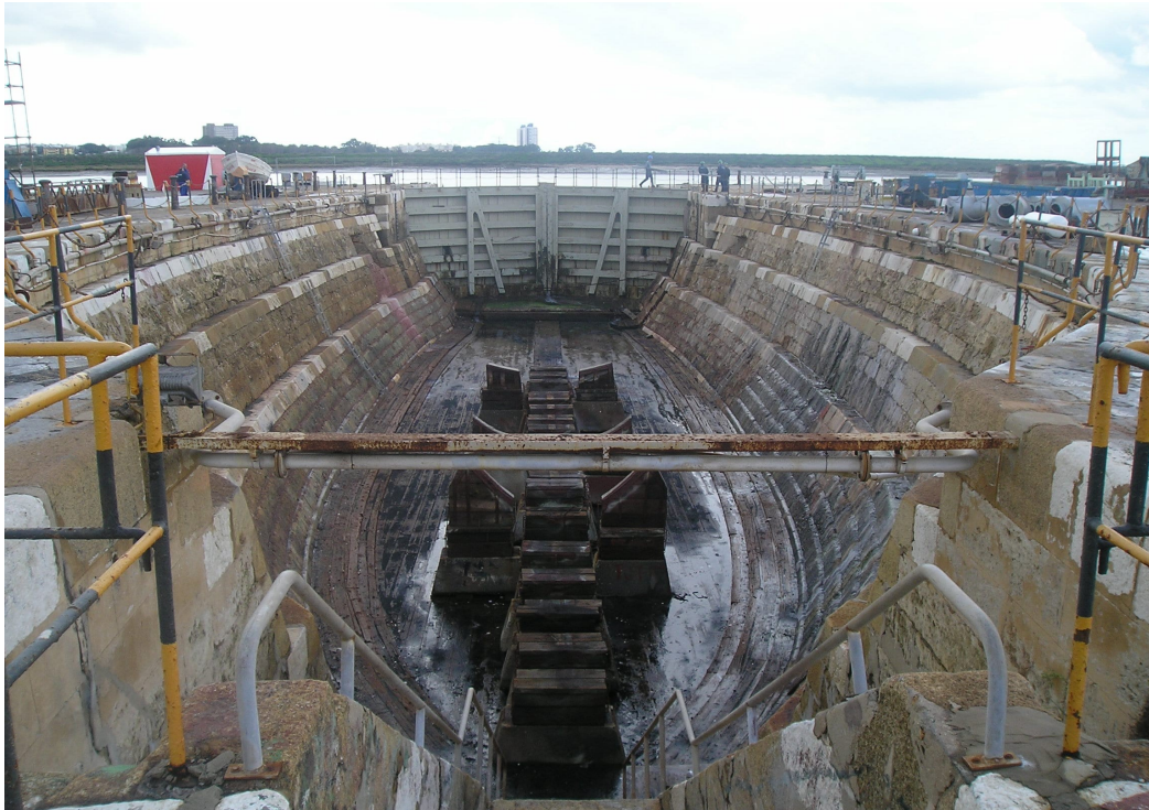
Imagen 22: Dique seco nº 3, llamado “San Antonio” construido por el ingeniero Tomás Muñoz en el siglo XVIII para la carena de navíos y embarcaciones de la Real Armada. Arsenal de La Carraca (San Fernando).(Foto: Vicente Ruiz García). Para su construcción no llegaron a emplearse las maderas de Segura, tal y como lo hicieron en los diques San Luis y San Carlos del mismo arsenal.
