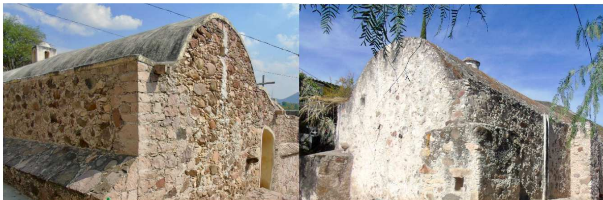
Fig. 13 y 14: Bóveda de la capilla de Don Bato (izquierda). Bóveda de la capilla de los Reséndiz (derecha). Fuente: Imágenes de la autora, 2017.
