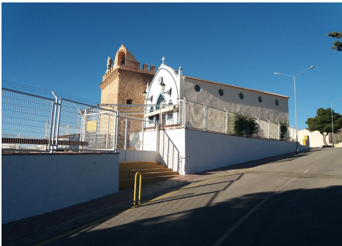
Figura 240. Torre de los Caballos y Ermita de Bolnuevo
