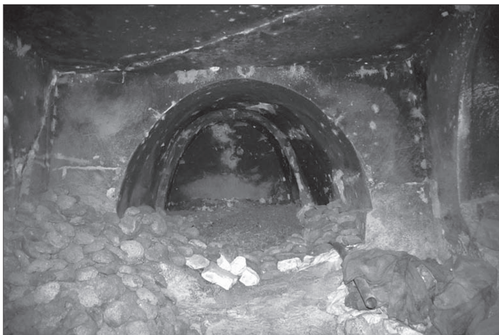
FIGURA 72. Vista del brazo lateral del hipogeo QM C3/54.
