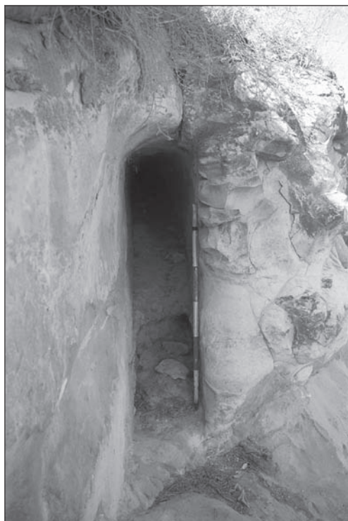
FIGURA 111. Wādī Ŷurum . Acueducto excavado en la roca
