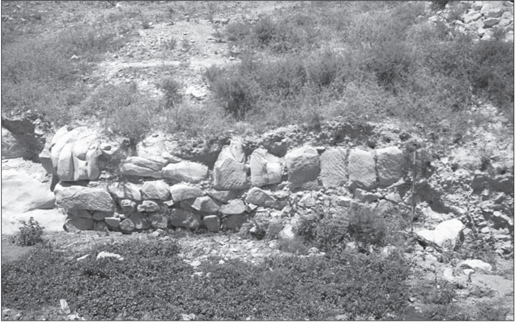
FIGURA 113. Wādī Yūrum. Unidad Constructiva n° 2
