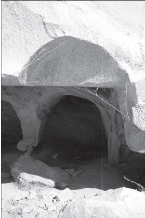
FIGURA 22. QM A-1. Fachada. Detalle
