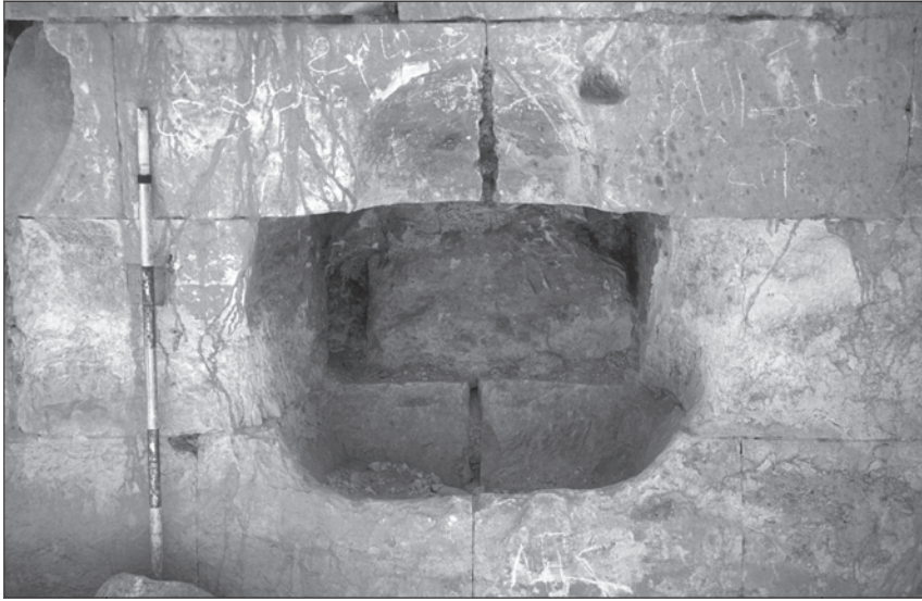
FIGURA 325. Detalle Muro este. Ýabal Balūna
