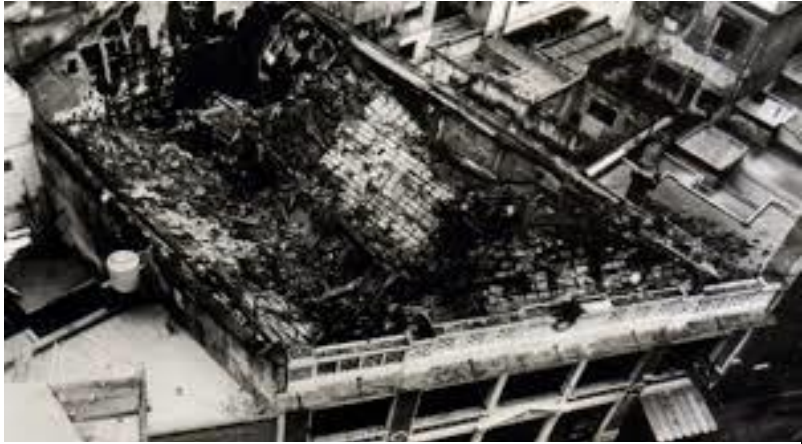
El Teatro del Picadero tras el incendio.
