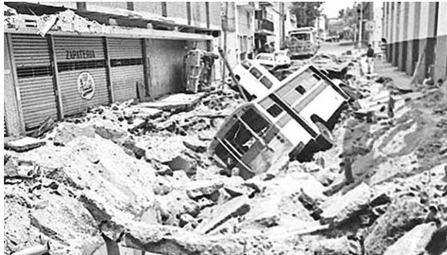
*Figura A.I.7.- Estado de una calle de Guadalajara (México), tras explosiones en el alcantarillado.*
