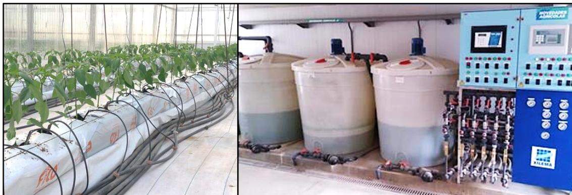
**Figura 11:** *Detalle de los goteros (izquierda) y las cubas de fertilizantes (derecha) en el invernadero.*
