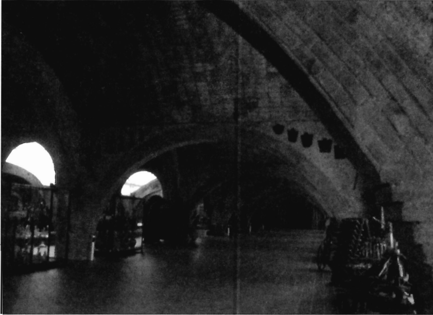
Lámina 5. Bodega de Codorniu, en Sant Sadurn d'Anoia, diseñada en 1895 por Josep Puig i Cadafalch.
