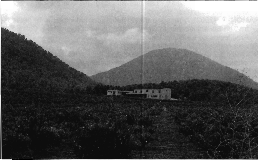
Lámina 12. CEVINCEV. Venta del Pino. Cehegín.
