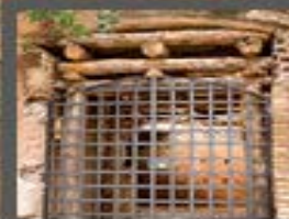
7. POLVORÍN Y SALA COMPRESORES
