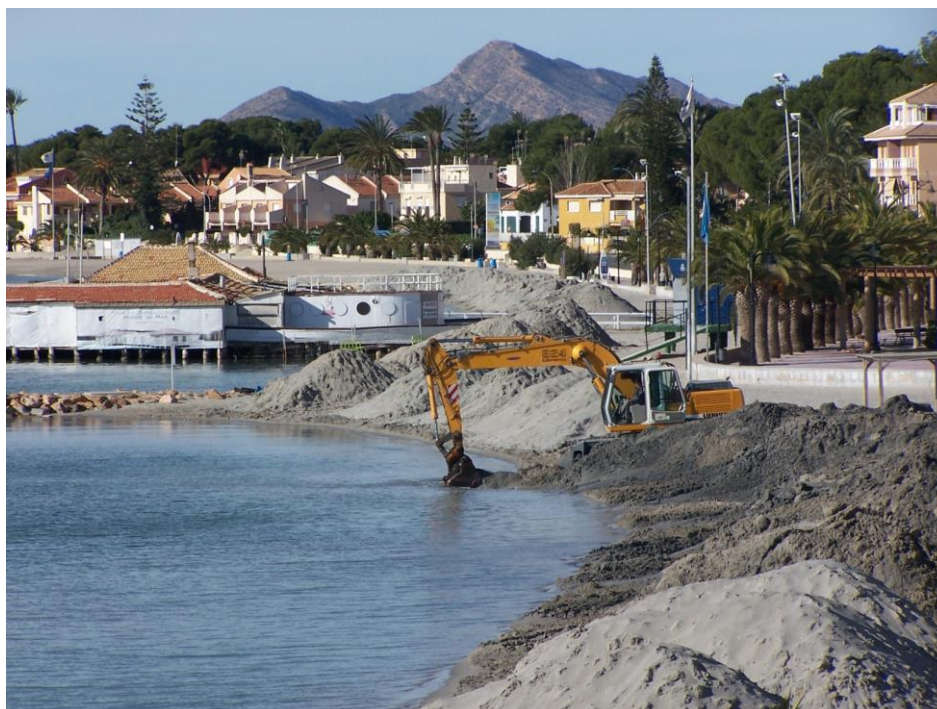
Figura 1.8. Acciones de dragado y de relleno de playas (Fotografía propia).
