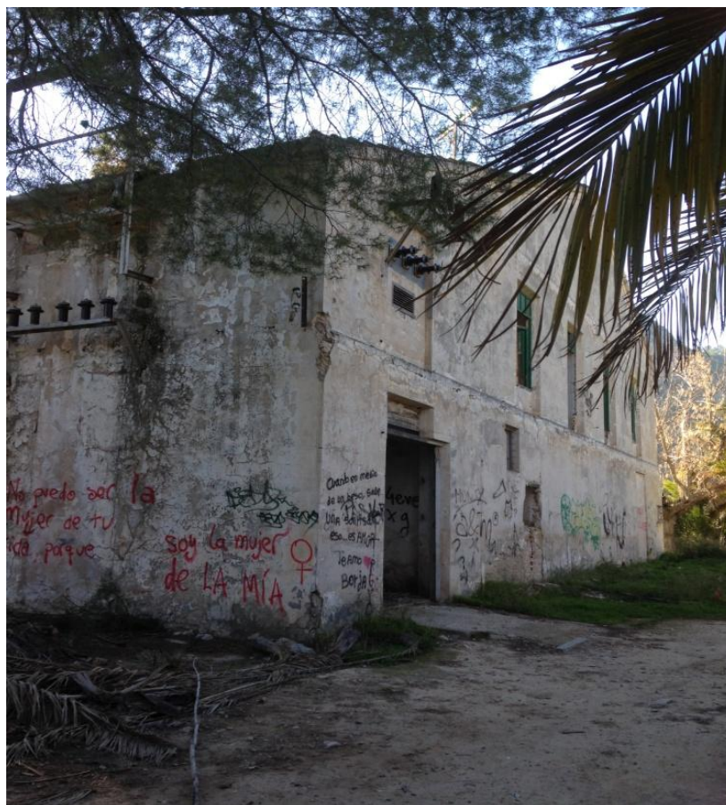
Figura 22. Aspecto que presenta en la actualidad la fábrica de luz. Fuente: M.D. Piñera.
