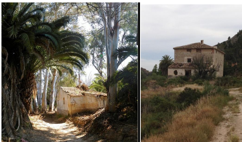
Figura 8. Estado actual de dos de los inmuebles. Fuente: http://farm4.static.flickr.com/3459/3374969457_b1ff7a4949.jpg
