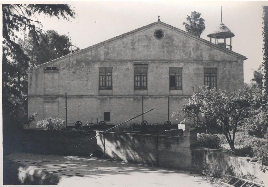
Figura 21. Aspecto que presentaba la fábrica antes de su cese. Fuente: AHI, Alcántara.
