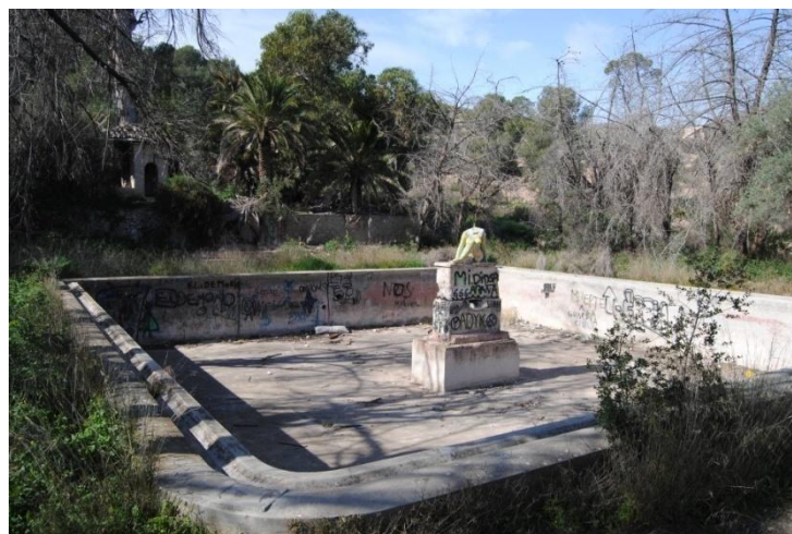
Figura 10. Estado actual de la fuente de la Diosa Aretusa. Fuente: http://fotos00.laopiniondemurcia.es/fotos/noticias/318x200/2009-11-30_IMG_2009-11-22_23.55.40_24-OMU-22112009.JPG ;
