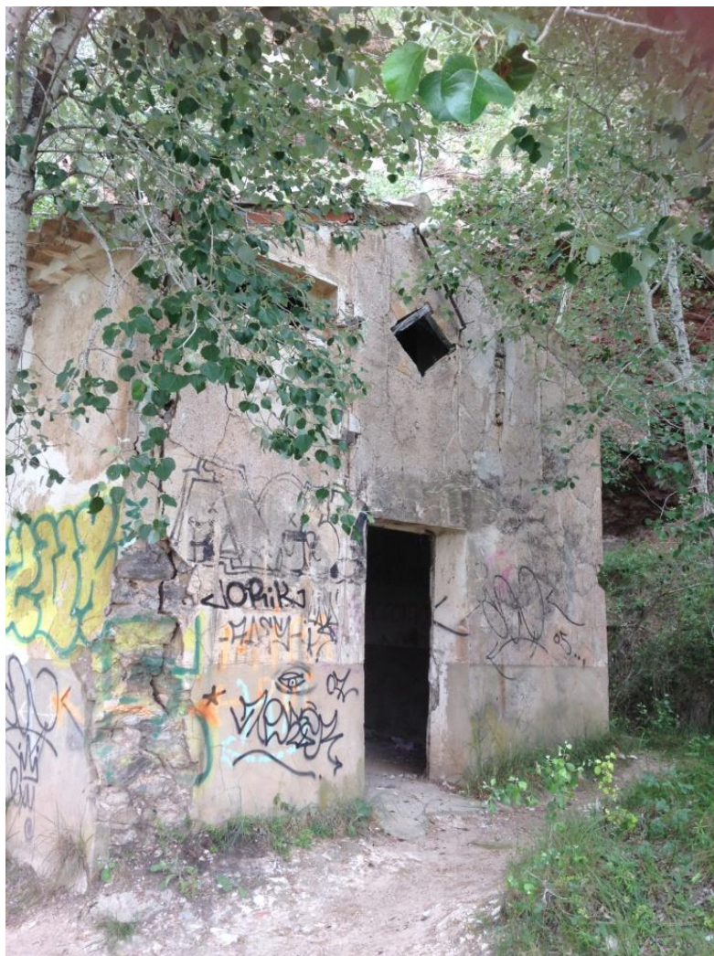
Figura 5. Casa del motor impulsor del agua de la acequia Charrara. Fuente: M.D. Piñera.
