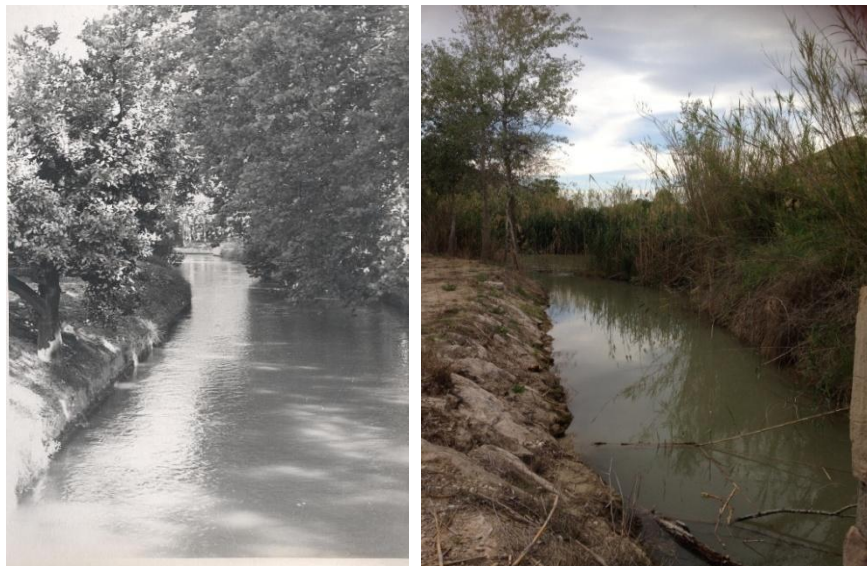
Figura 9. Canal de derivación de agua para la fábrica de luz, antes. Fuente: AHÍ, Alcántara y en la actualidad. Fuente: M.D. Piñera
