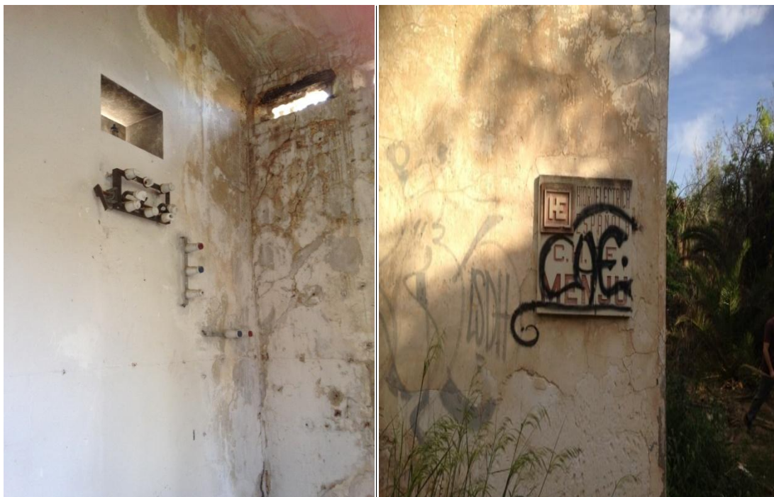
Figura 23. Detalles del aspecto interior y exterior del edificio. Fuente: M.D. Piñera.
