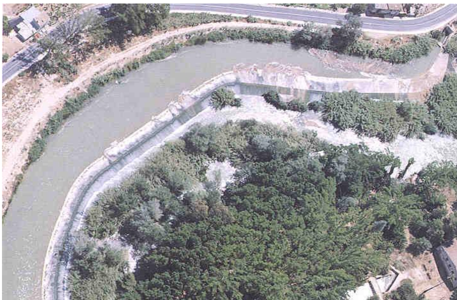
Figura 29. Presa del Menjú en la actualidad. Fuente: SEPREM.
