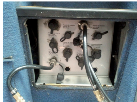
Figura 16: Autobús (tomas de presión centralizadas e identificadas)
