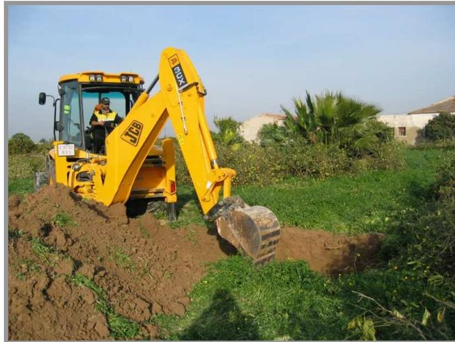
**Foto 8. Pala excavadora realizando la calicata de un perfil**
