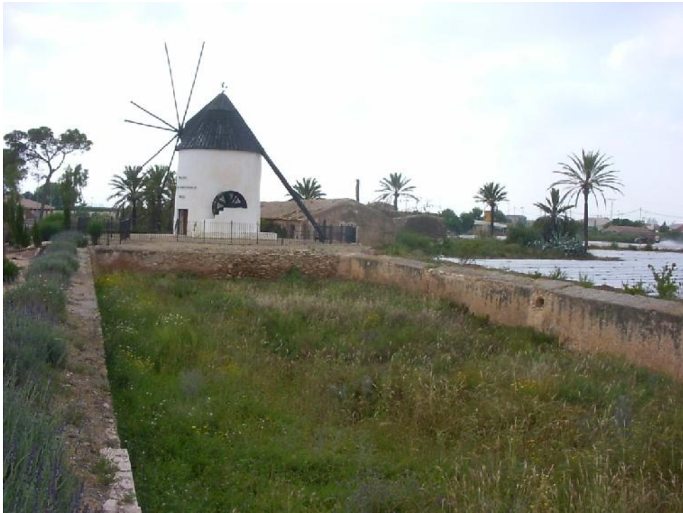
Molino de agua de "la hortichuela", con balsa de acopio de agua.
