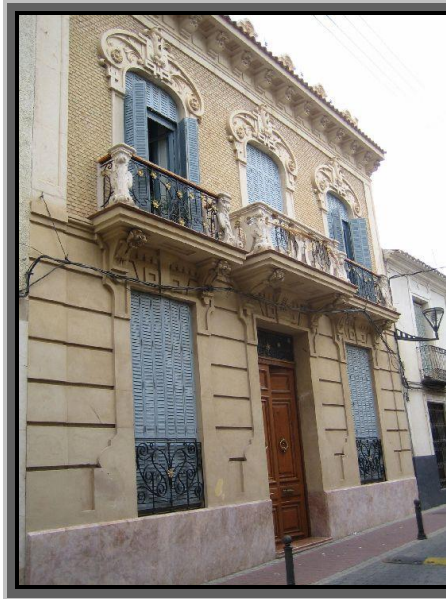
Figura 17. Casa Convento. Fuente: J. A. Díaz.
