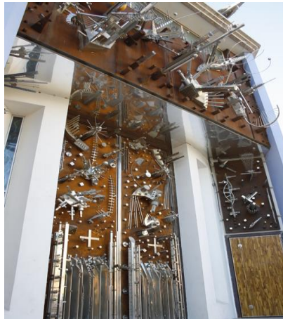
Figura 67 Fachada Iglesia de Santa Clara en Cieza. José Lucas
