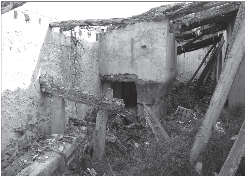
FOTO 4. En primer término, los restos de la viga de la prensa 1 entre las vírgenes; al fondo, la torre contrapeso con el dintel y la entrada lateral de la capilla.
