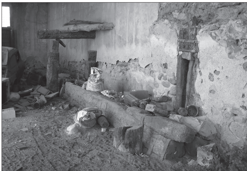
FOTO 6. Prensa 3 situada junto al muro de la fachada. En primer término conserva una parte de la cárcel y, en el centro, ambos maderos de las vírgenes.
