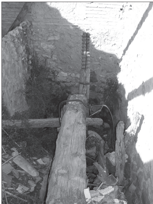
FOTO 5. Extremo de la viga de la prensa 1 con el husillo de madera de pie y el contrapeso en el fondo del foso.
