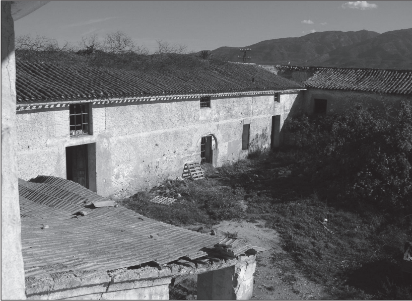
FOTO 7. Fachada interior de la nave este. Los revocos dejan traslucir las antiguas arcadas con rosca de ladrillo de la cuadra y los vanos del almiar superior.
