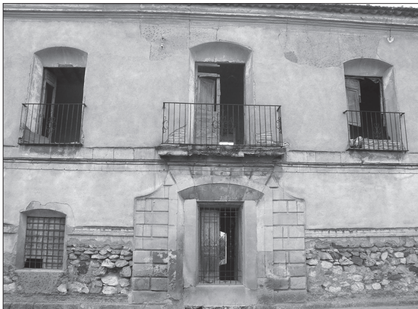
FOTO 2. Entrada principal de personas que define el eje de simetría central de la fachada. Fábrica de sillería de cantería con un suave almohadillado característico del final del barroco.
