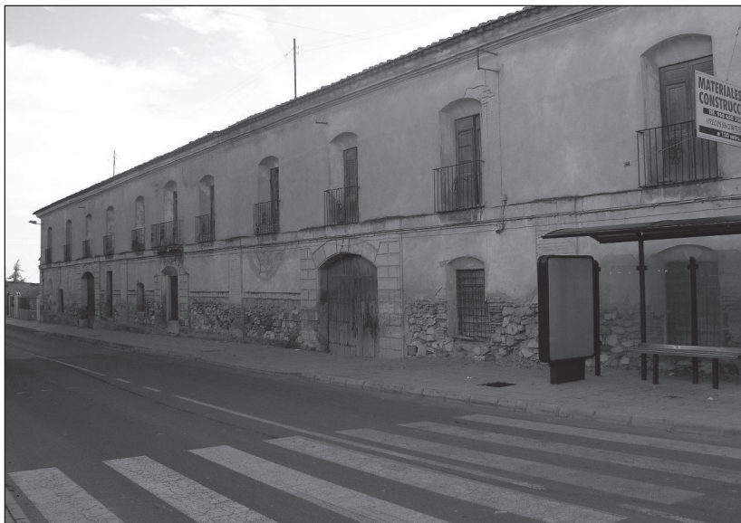
FOTO 1. Fachada principal de la antigua Posada de Librilla (1780-1783).
