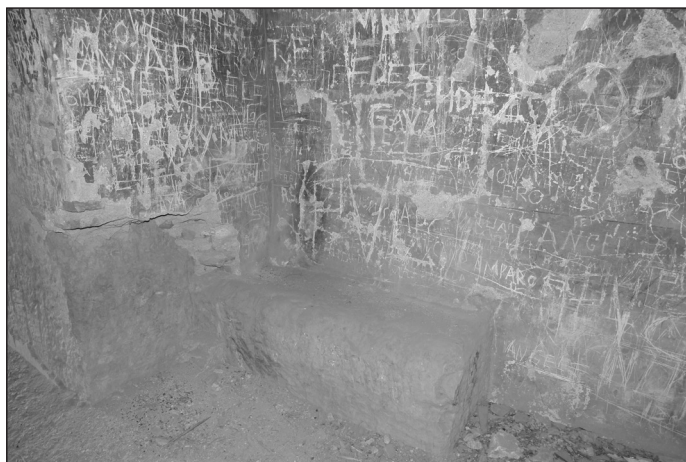
Figura 4. Asiento excavado en la arcilla.
