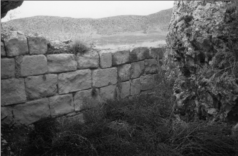
LÁMINA 1. Presa de la fuente de Pedrarias.
