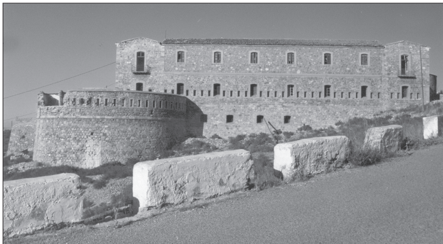
Cuartel Defensivo de monte de Fajardo. A la izquierda el Tambor bajo el cual se haya el Aljibe. (Foto Agoviz).
