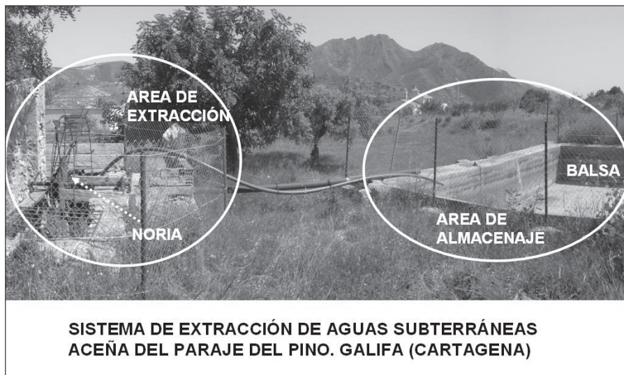
LÁMINA 3. Vista general de una aceña. Zonificación según funcionalidad.
