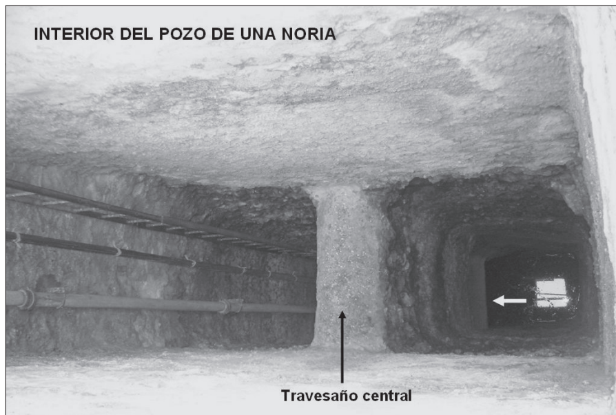
LÁMINA 5. Interior del pozo de la noria.
