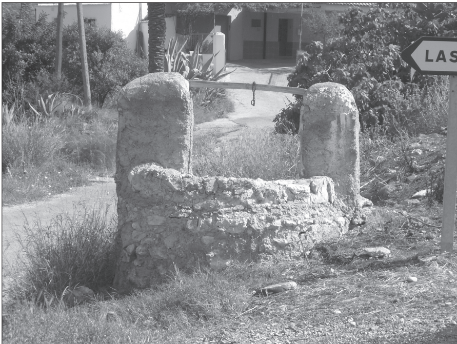
LÁMINA 8. Pozo junto a la Rambla del Portús.
