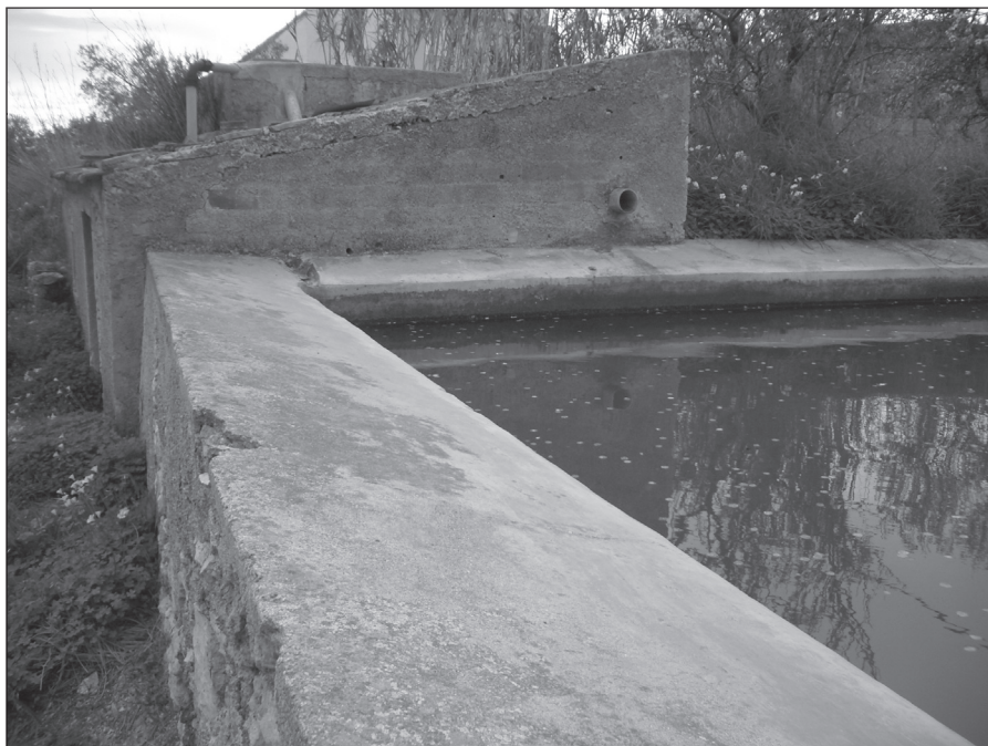
LÁMINA 7. Detalle del muro de la balsa.
