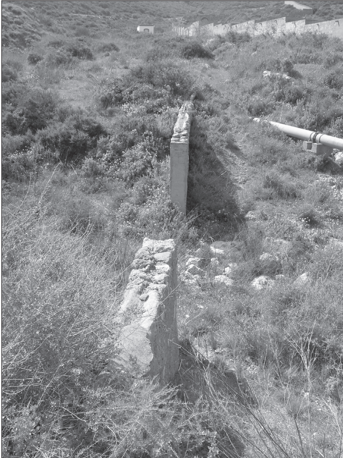
FIGURA 7: Restos del acueducto que conducía las aguas del Calvario hasta un depósito en el que se unía su caudal con las aguas procedentes del manantial de San Juan. Cartagena.
