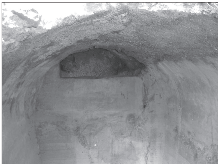
FIGURA 9: Interior del depósito en el que se reunían las aguas de San Juan y las del Calvario. En concreto, compartimentación para filtrar el agua. Junto al cementerio de Ntra. Sra. de los Remedios. Cartagena.
