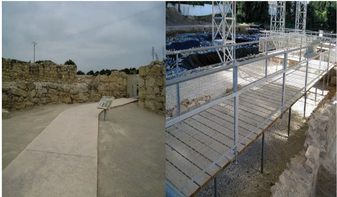
Ilustración 4. Pasarelas reversibles en Lucentum , Alicante (izquierda) y en el Museo al Aire Libre Villa Romana del Albir, Alfaz del Pi (derecha)
