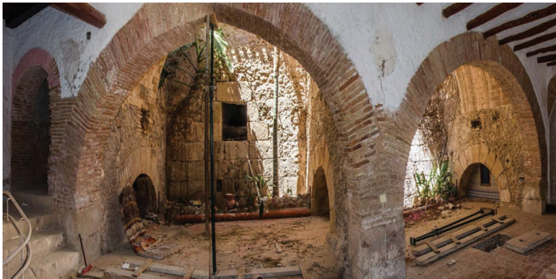
Ilustración 6. Interior del edificio del batán. Grandes arcos de ladrillo y salidas del agua en la pared. Fotografía realizada por María Trinidad Albaladejo Soler, 2013, Lorca
