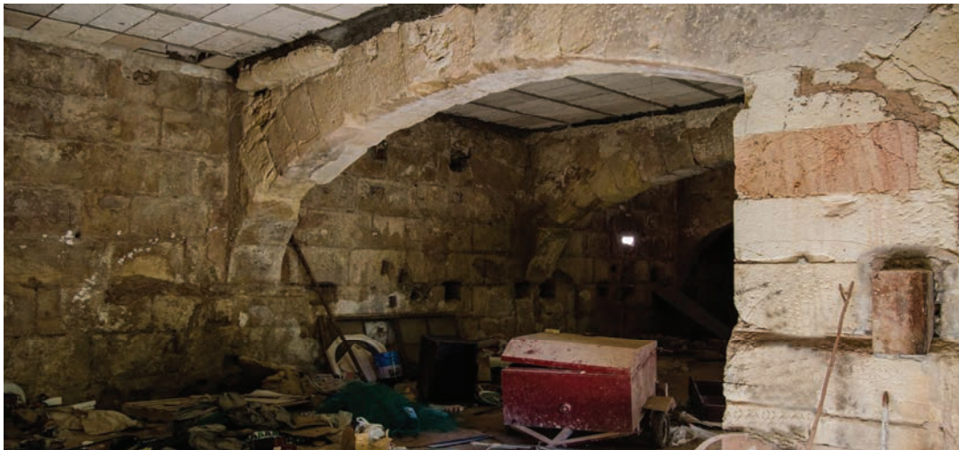
Ilustración 2. Interior del molino de cubo. Muros y arcos de grandes sillares de piedra. Fotografía realizada por María Trinidad Albaladejo Soler, 2013, Lorca
