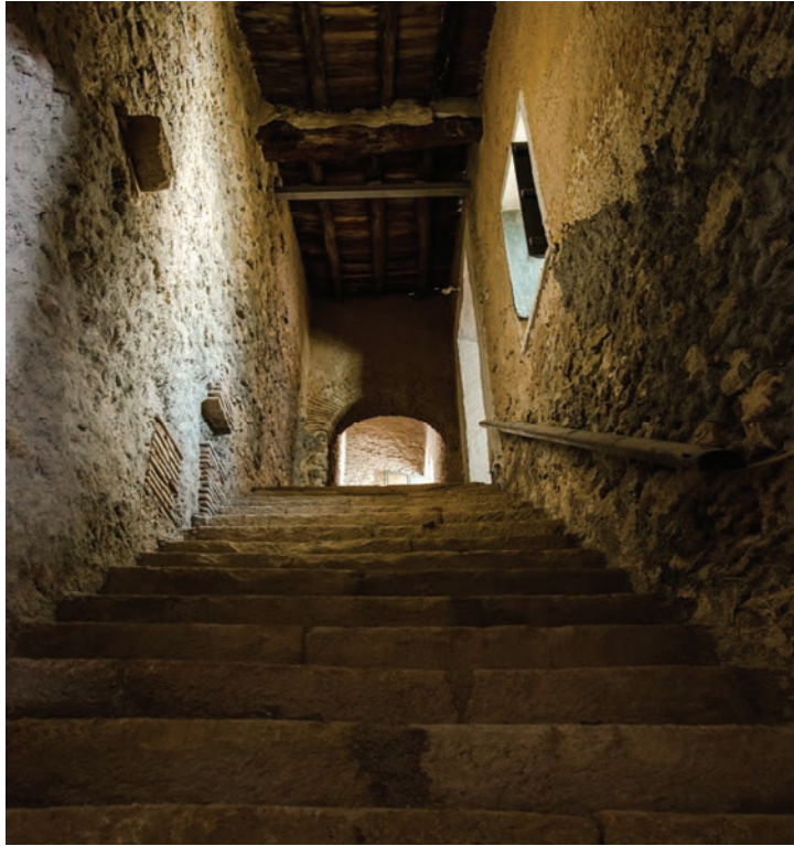
Ilustración 5. Escalera de sillares de piedra que accede a todos los niveles del batán. Fotografía realizada por María Trinidad Albaladejo Soler, 2013, Lorca
