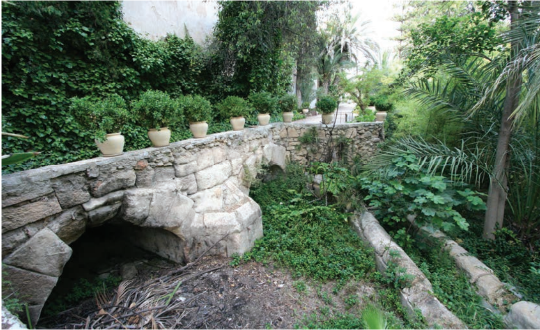
Ilustración 3. Cárcavos y Acequia que recoge las aguas sobrantes. Fotografía realizada por María Trinidad Albaladejo Soler, 2013, Lorca
