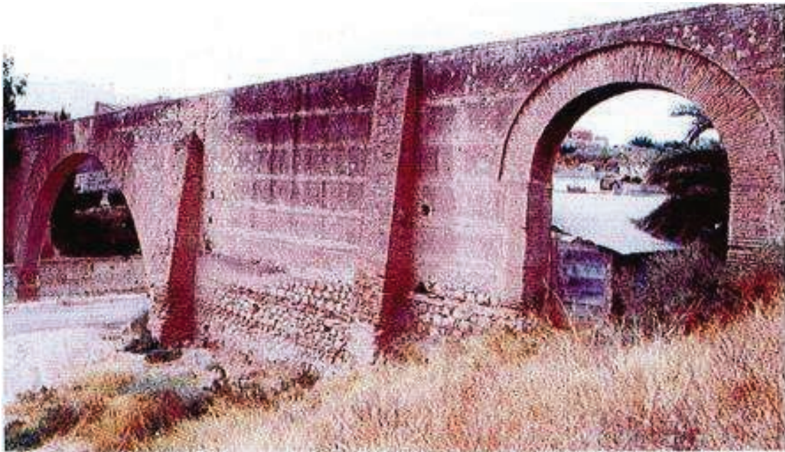
Ilustración 3. Arco del Prado (1753), la obra más importante de todo el sistema de construcciones hidráulicas de la villa
