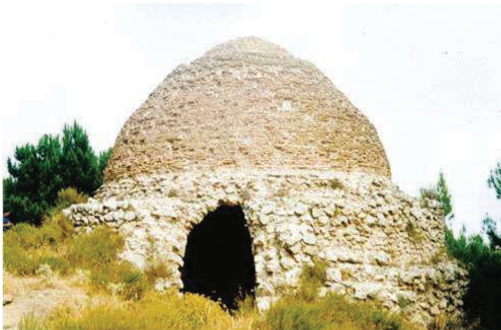
Ilustración 5. Pozo de nieve de Sierra Espuña, perteneciente a la ciudad de Cartagena, el único que nos ha llegado íntegro desde su construcción en el siglo XVIII
