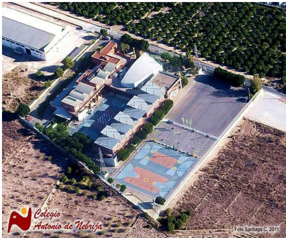
Ilustración 2.2. Edificio del colegio Antonio de Nebrija. Fuente: Web del colegio
