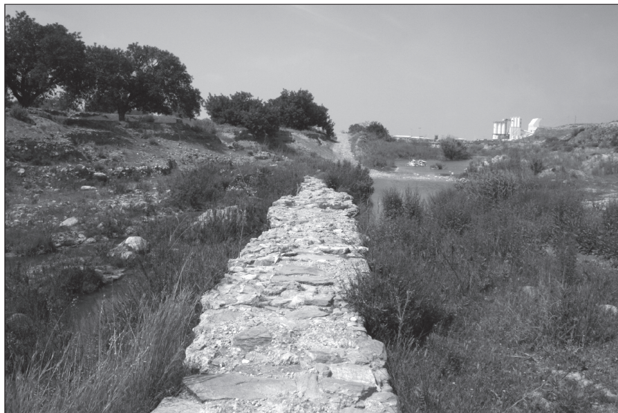
FOTO n° 8: La galería como canal para atravesar el cauce de la rambla.
