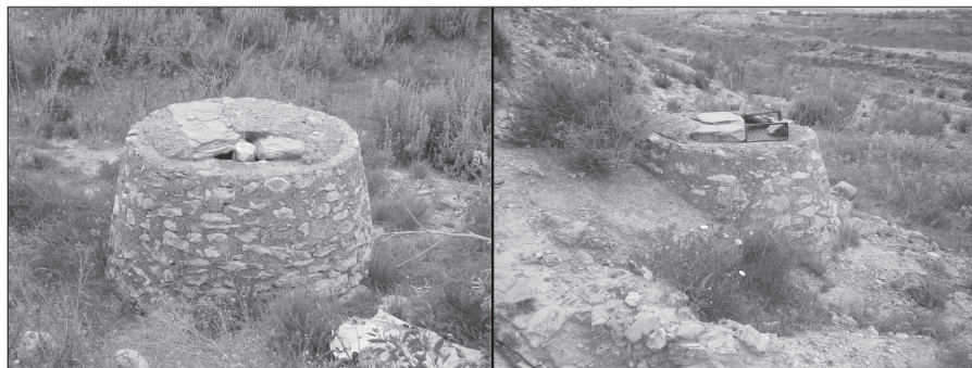
FOTO n° 15: Lumbreras del Sistema de Corverica.
