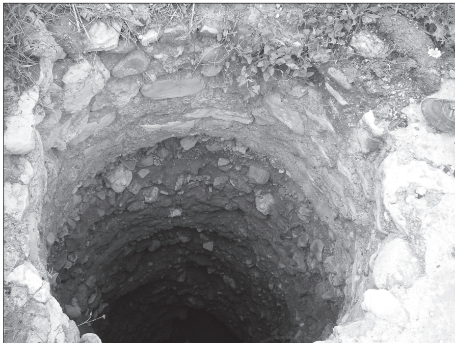
FOTO n° 2: Lumbrera y galería excavada en la margen derecha de la Rambla de la Azohía.
