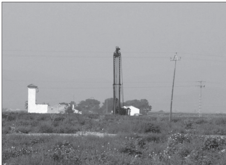
FOTO n° 11: Apertura de pozos profundos y nuevos sondeos ocasionan la bajada de los niveles de los acuíferos.
