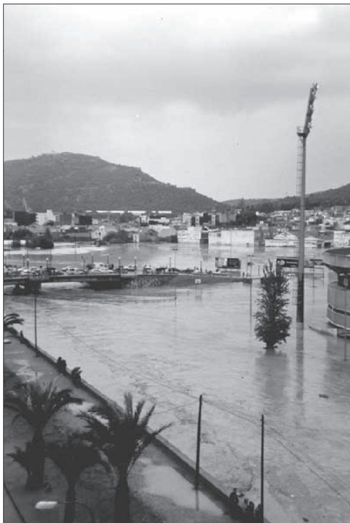
FIGURA 3. Desbordamiento de la Rambla de Benipila en su margen derecha a su paso por la ciudad de Cartagena, Octubre de 2002. (Fuente: www.asociacionanse.org )
