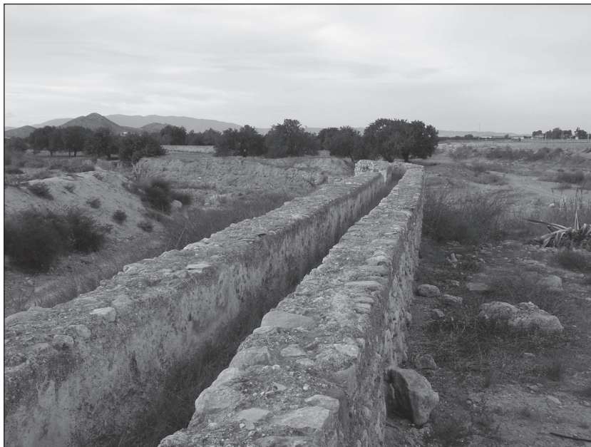
FOTO 11. Canalización del riego viejo de Fuente Álamo.
