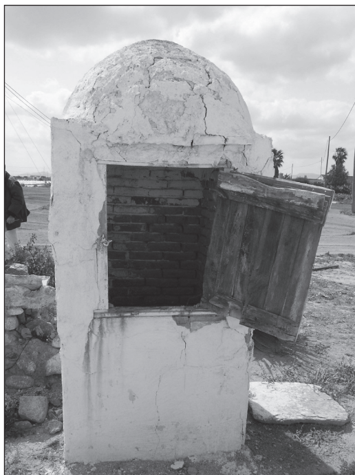
FOTO 9. Aljibe de agua fresca. Vista general.
