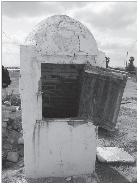
FOTO 8. Aljibe de agua fresca. Acceso exterior.
