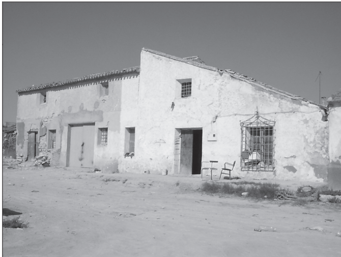
Casa de los Capellanes en la zona de la Rambla honda, muy deteriorada pero se observa la estructura típica de las casas solariegas.
