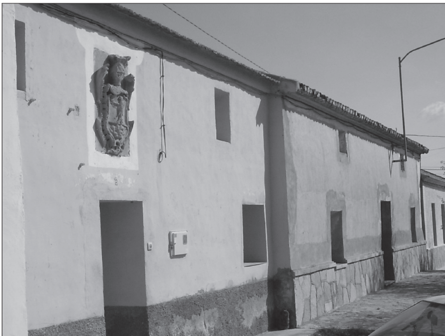
Casas de la familia Roca, rama Molineros, sita el caserío de El Molino, entre el núcleo urbano de la Ermita del Jimenado y los Rocas Viejos.
