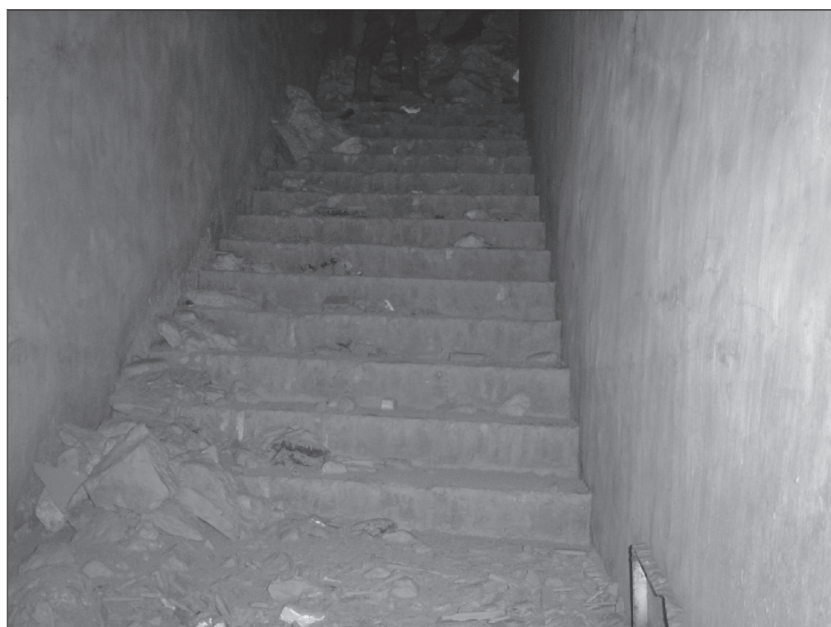
LÁMINA 7: Escalera en sector 3B.
