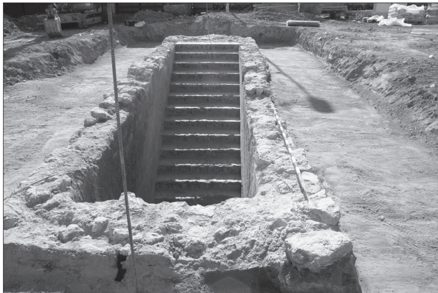
LÁMINA 3: Escalera de acceso al refugio. Sector 1A.
