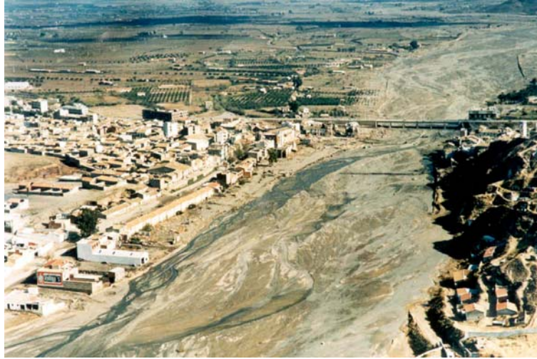
Fig.1. Daños de la inundación de octubre de 1973, por la Rambla de Nogalte, en Puerto Lumbreras (foto cedida por el Alcalde de esta localidad).
