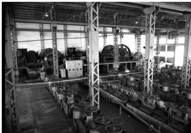
Figura 1. 16. Interior del Lavadero Roberto, con los molinos de bolas al fondo, donde se tritura el material y en primer término las celdas donde se forma la espuma y se separan los estériles (Archivo General de la Región de Murcia, 2014).
