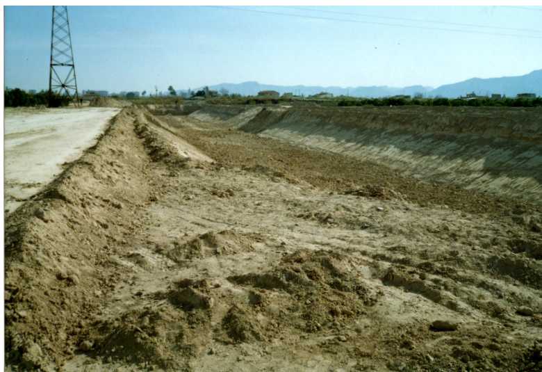
Figura 101. Obras de encauzamiento del Río Segura a su paso por Rincón de Beniscornia al inicio de los años 90. Excavación del nuevo cauce.
