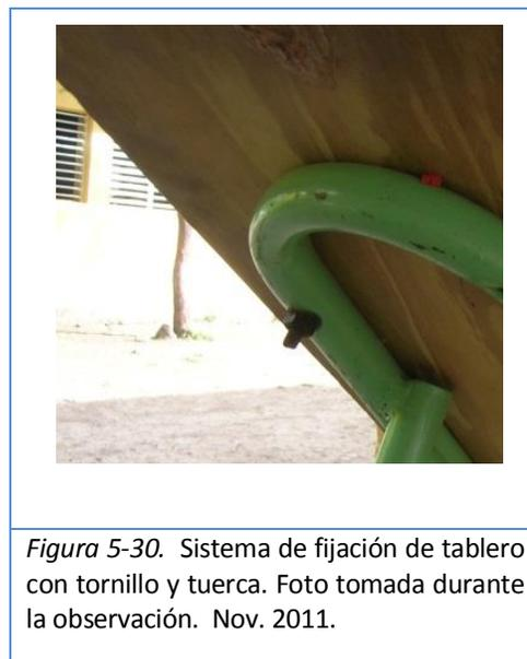
Figura 5-30. Sistema de fijación de tablero con tornillo y tuerca. Foto tomada durante la observación. Nov. 2011.
