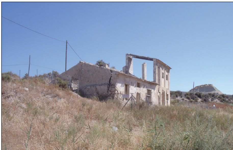
FIGURA 7. Ruinas del Molino de la Huerta y casa del molinero
