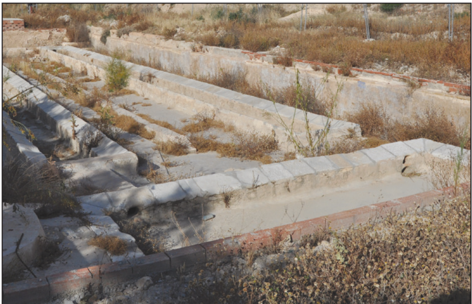
FIGURA 6. Restos del lavadero de la Fuente del Ojo
