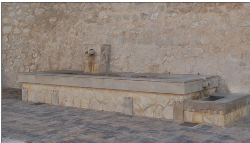
FIGURA 4. Abrevadero del «Pilar de Los Burros», en el Camino de Madrid
