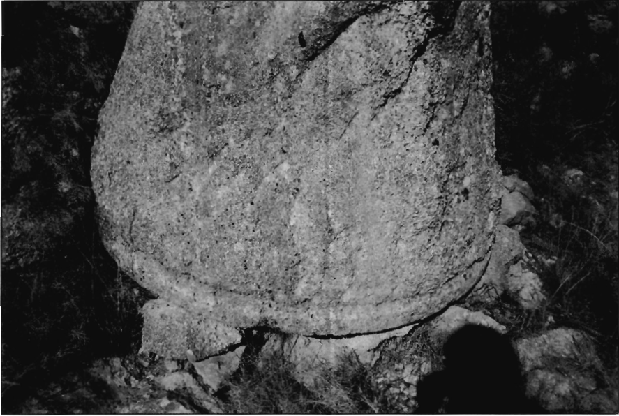
Foto 9. Rulo de almazara I. Detalle de los calzos colocados para poderlo trabajar en su parte inferior.
